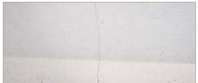
Abb. 61: Beispiel oberflächlicher Riss
