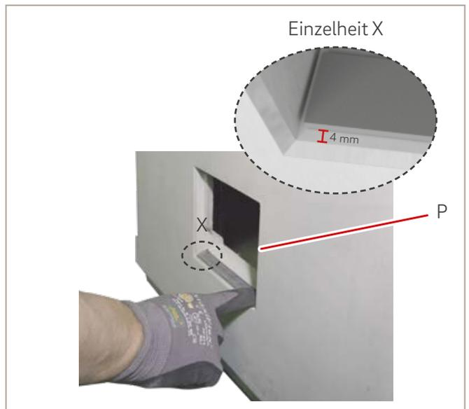
Abb. 40: Revision Dichtungsband 220 mm unten einkleben
