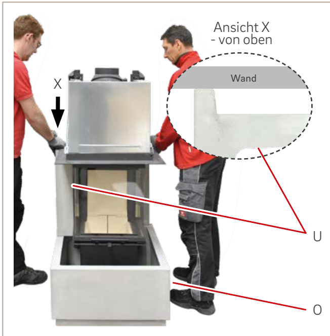
Abb. 42: Seitenteil lang setzen
