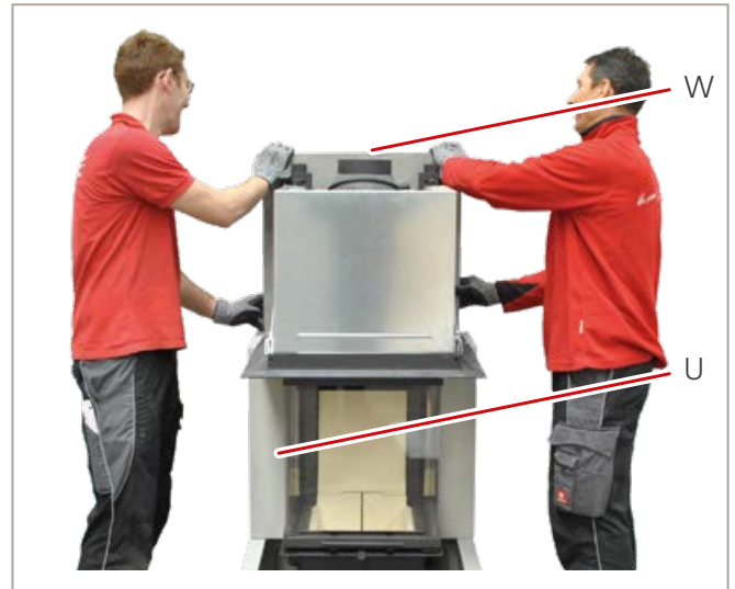
Abb. 44: Rückwand 2 setzen
