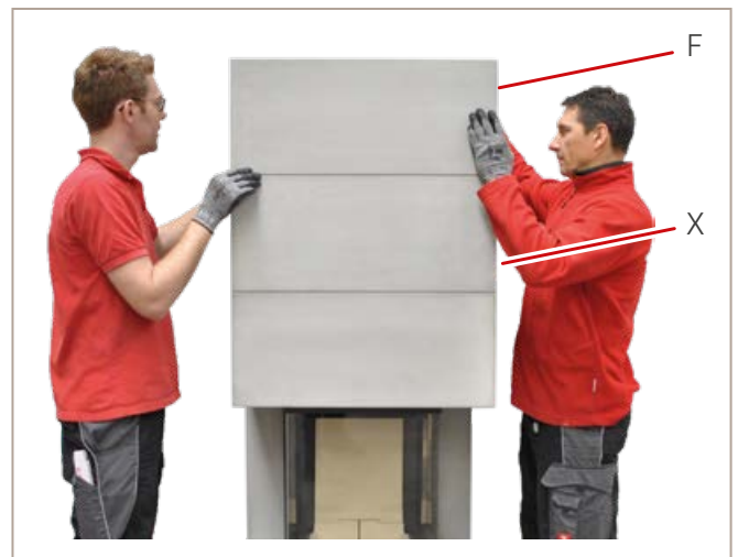
Abb. 49: Oberbauteil 3 setzen
