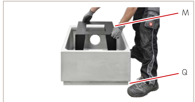
Abb. 28: Traglager platzieren
