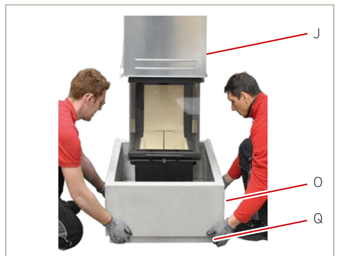
Abb. 38: Unterbauteil 1 setzen
