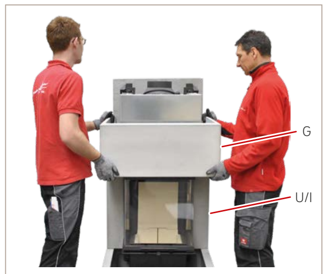
Abb. 45: Oberbauteil 1 setzen
