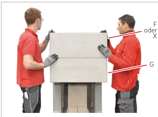
Abb. 47: Oberbauteil 2 setzen
