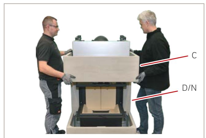
Abb. 43: Oberbauteil 1 setzen
