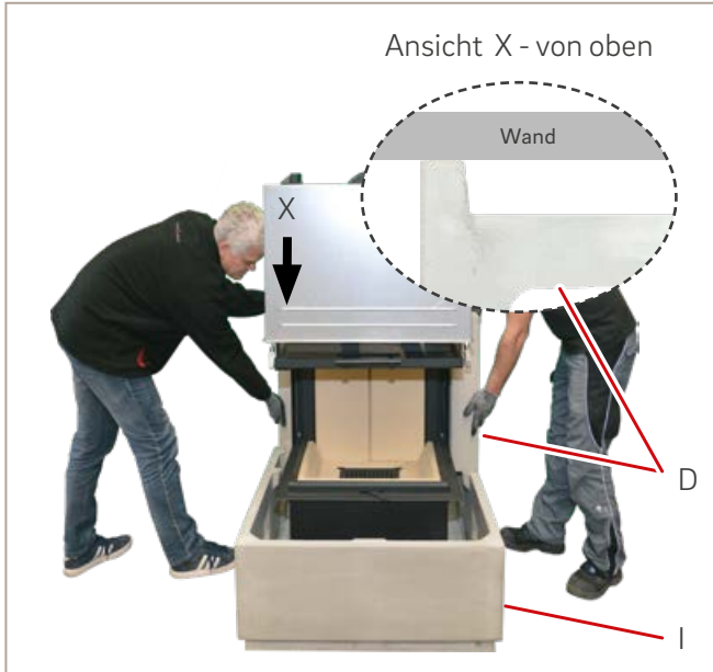
Abb. 40: Seitenteil lang setzen
