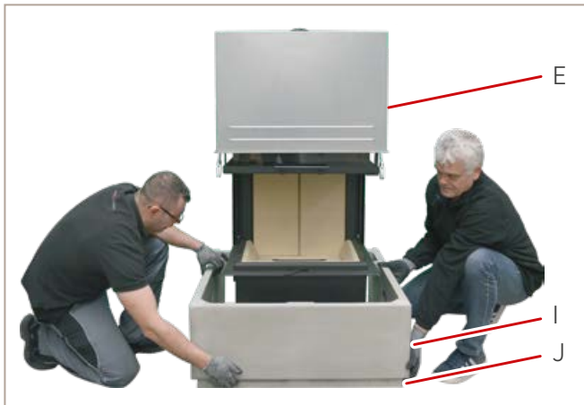
Abb. 37: Unterbauteil setzen
