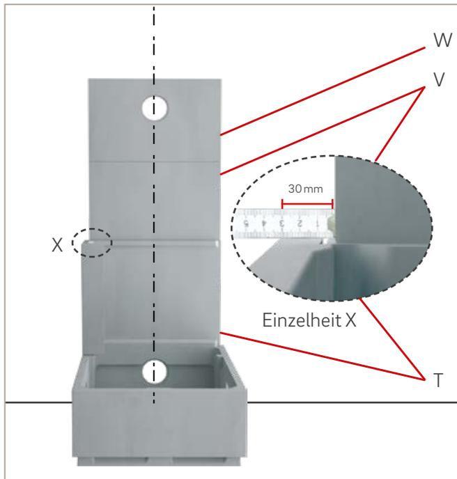
Abb. 18: Rückwand 2 und Rückwand 3 setzen
