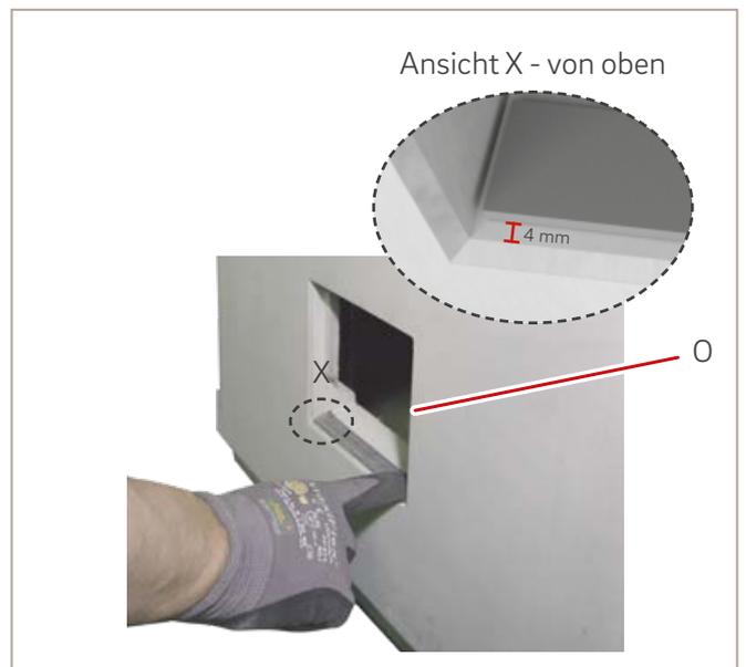
Abb. 47: Revision Dichtungsband 140 mm unten einkleben
