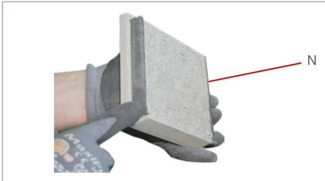
Abb.48: Revision Dichtungsband 120 mm links und rechts einkleben
