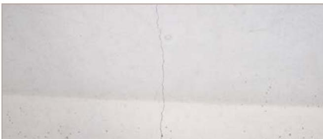
Abb. 70: Beispiel oberflächlicher Riss
