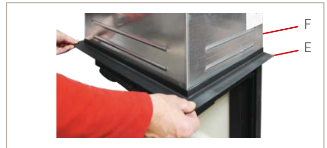
Abb. 33: Sturzblende setzen
