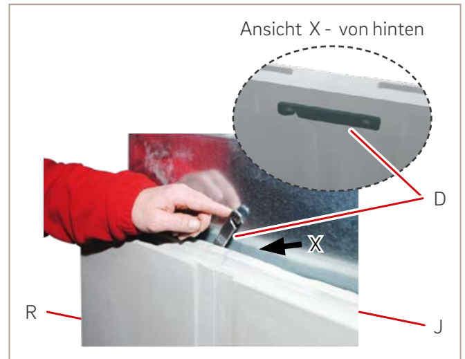
Abb. 37: Verbindungsglasche oben schließen
