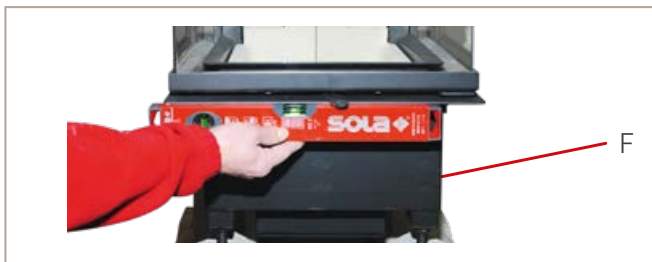
Abb. 29: Kamineinsatz mit Wasserwaage ausrichten.
