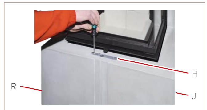
Abb. 38: Verbindungsglasche unten montieren
