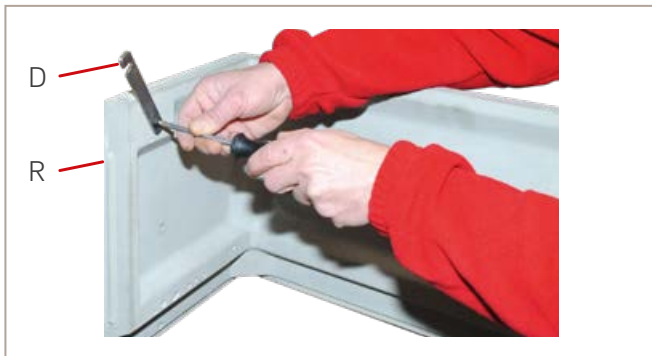
Abb. 35: Verbindungsglasche oben montieren
