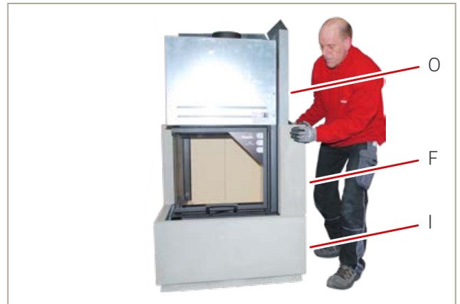
Abb. 36: Seitenteil kurz setzen
