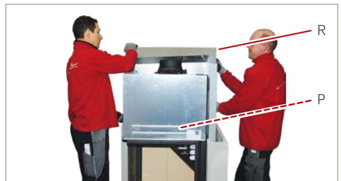
Abb. 37: Rückwand 2 setzen
