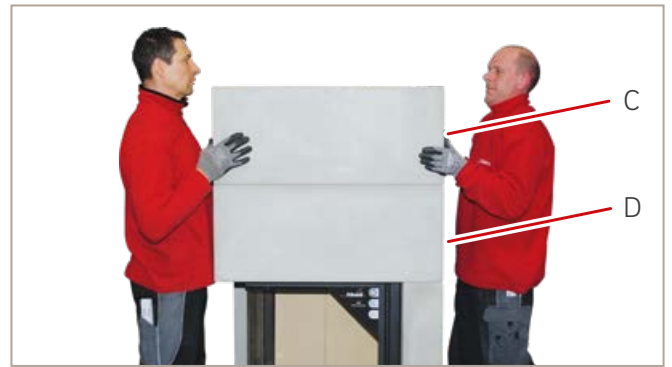
Abb. 40: Haubenteil setzen
