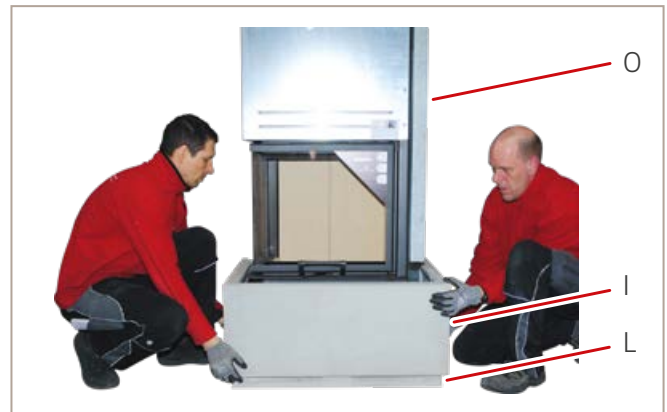
Abb. 32: Unterbauteil 1 setzen
