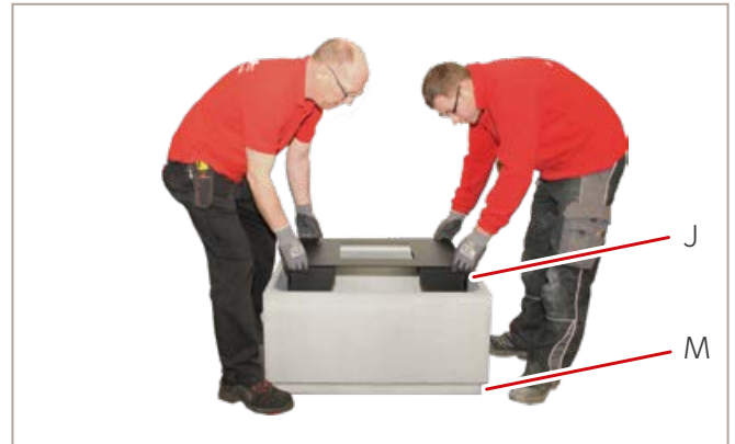
Abb. 24: Traglager platzieren
