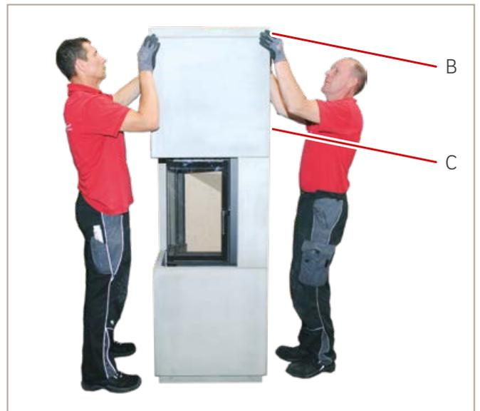
Abb. 32: Deckenplatte setzen
