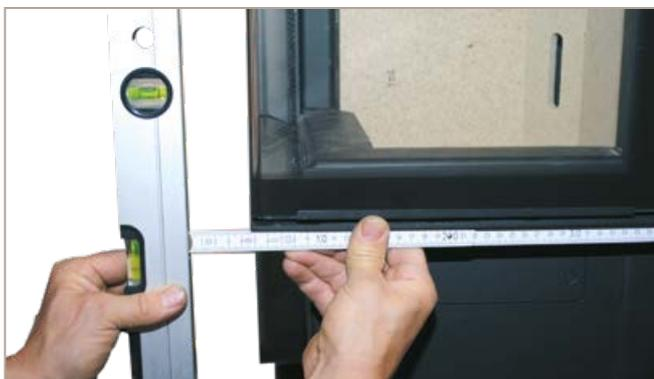
Abb. 18: Kamineinsatz auf dem Traglager ausrichten
