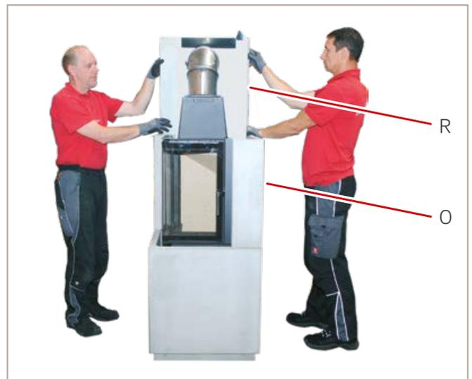
Abb. 28: Rückwand 2 setzen
