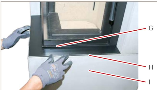
Abb. 34: Bankplatte setzen
