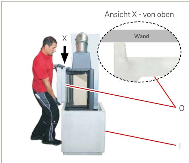
Abb. 26: Seitenteil lang setzen
