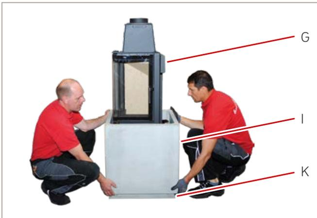
Abb. 22: Unterbauteil setzen
