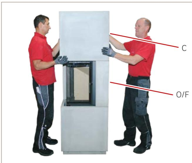
Abb. 30: Oberbauteil setzen
