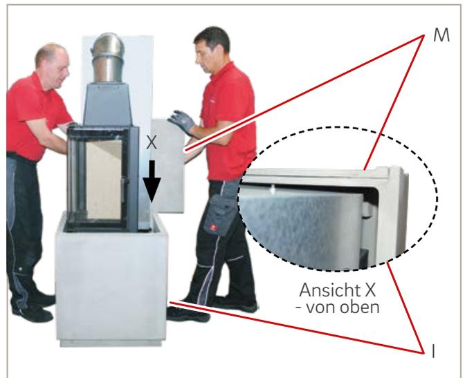
Abb. 25: Rückwand 1 setzen
