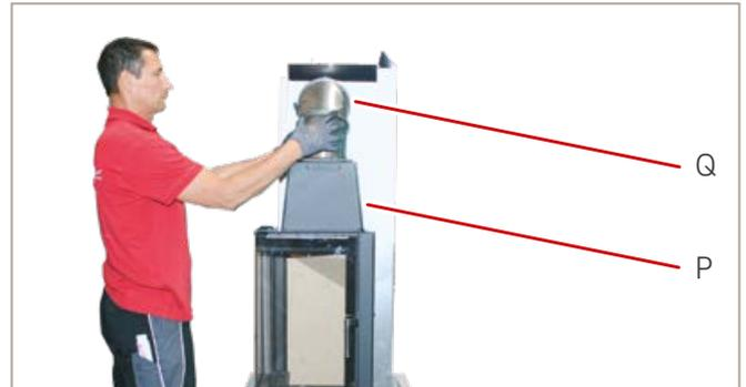
Abb. 24: Abgasrohrbogen montieren
