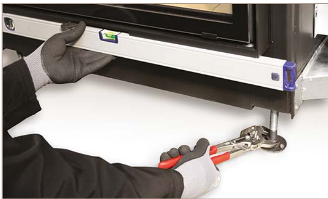
Abb. 16: Kamineinsatz ausrichten
