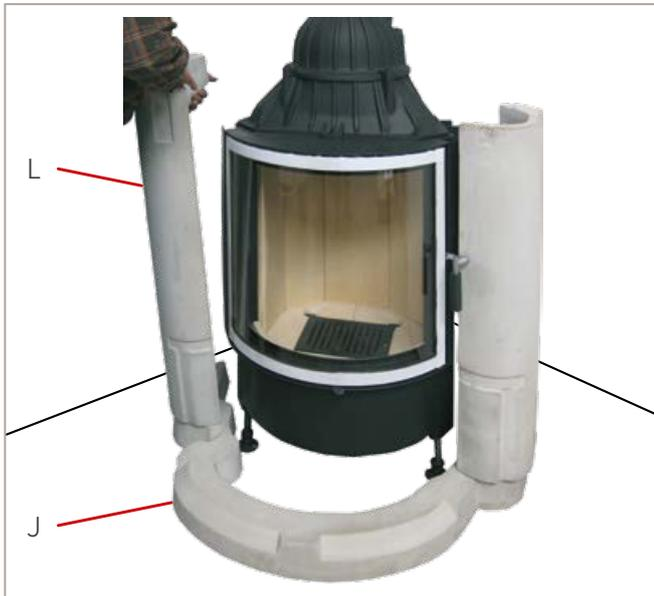
Abb. 19: Seitenteil rechts setzen
