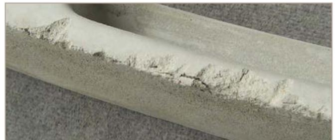
Abb. 49: Beispiel oberflächliche Abplatzungen
