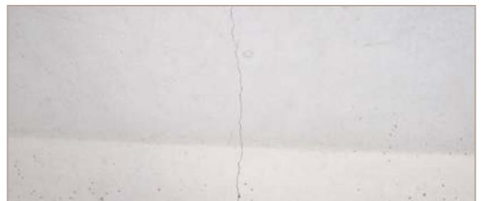
Abb. 50: Beispiel oberflächlicher Riss
