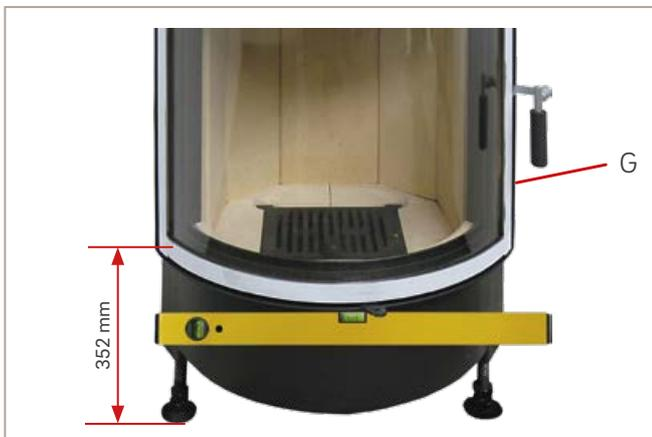
Abb. 13: Kamineinsatz positionieren und ausrichten
