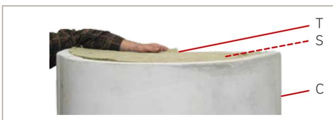
Abb. 25: Dämmwolle platzieren
