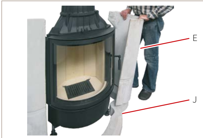
Abb. 19: Seitenteil rechts setzen
