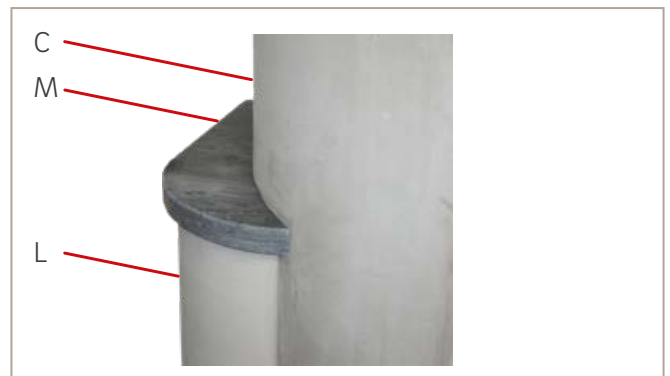
Abb. 31: Naturstein-Abdeckplatte Seitenteil links setzen
