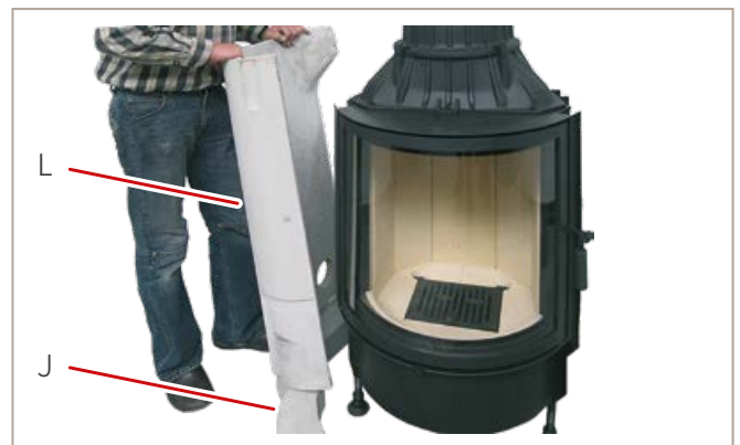
Abb. 18: Seitenteil links setzen
