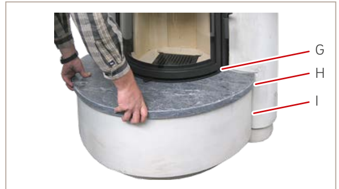
Abb. 30: Naturstein-Bankplatte setzen
