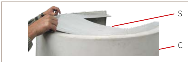
Abb. 24: Trägerplatte Dämmung platzieren
