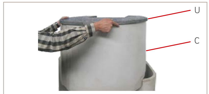
Abb. 26: Naturstein-Abdeckplatte Oberbauteil platzieren
