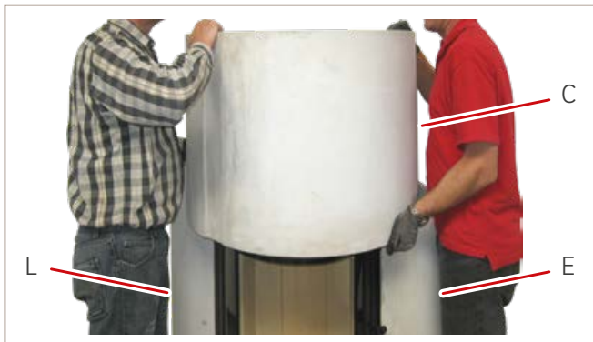
Abb. 23: Oberbauteil platzieren
