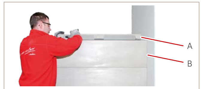
Abb. 52: Deckenplatte setzen
