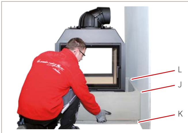
Abb. 41: Unterbauteil vorn setzen
