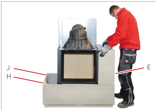
Abb.20: Seitenteil rechts setzen
