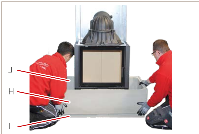
Abb.19: Unterbauteil vorn setzen
