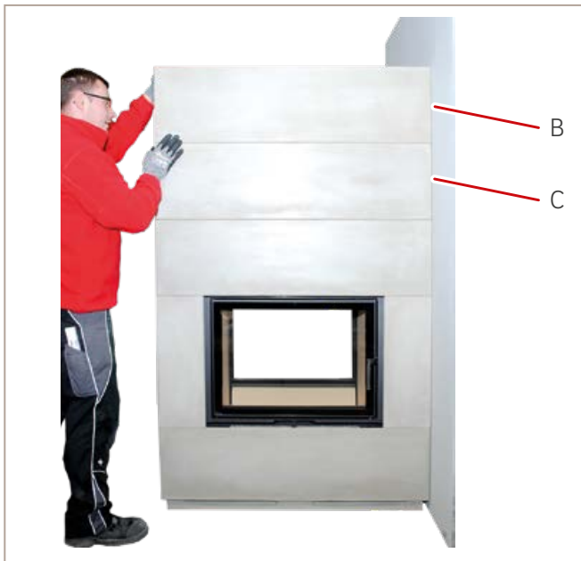
Abb.48: Oberbauteil 3 setzen
