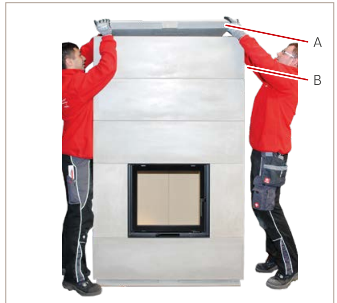
Abb. 27: Deckenplatte setzen
