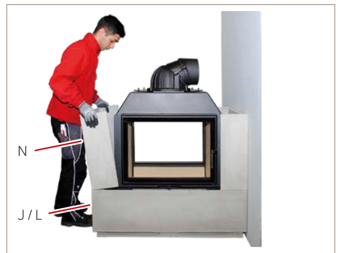
Abb. 43: Seitenteil links setzen
