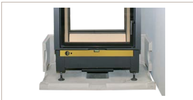
Abb. 38: Kamineinsatz ausrichten
