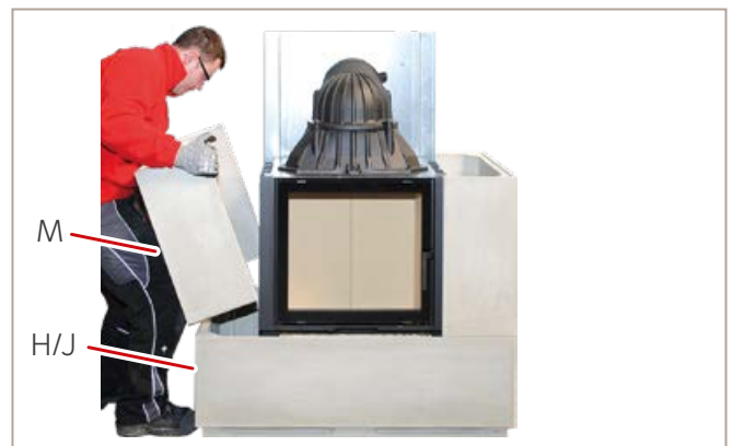
Abb.22: Seitenteil links setzen
