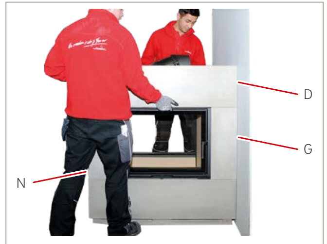
Abb. 46: Oberbauteil 1 setzen
