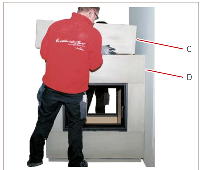
Abb. 47: Oberbauteil 2 setzen
