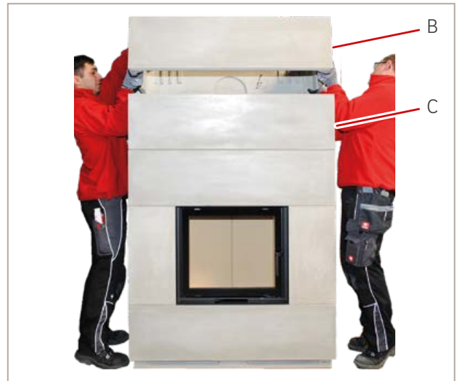
Abb. 25: Oberbauteil 3 setzen
