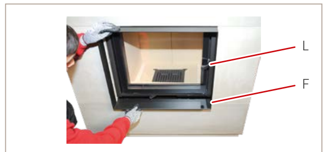
Abb. 28: Blendrahmen positionieren
