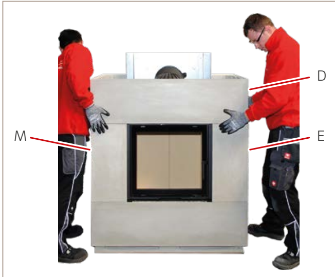
Abb. 23: Oberbauteil 1 setzen
