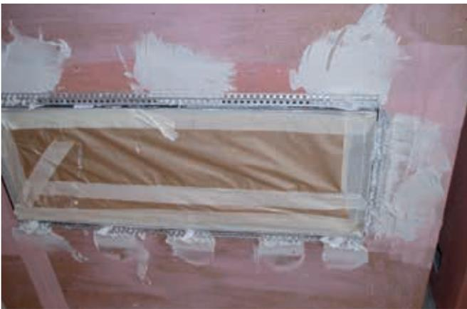
Danach werden rund um den Einbaurahmen in 2 mm Abstand vom Einbaurahmen Putzprofile montiert.
